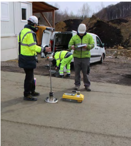
Abbildung 2: Einbaukontrolle mit Troxlersonde sowie leichtem Fallgewichtsdeflectometer
