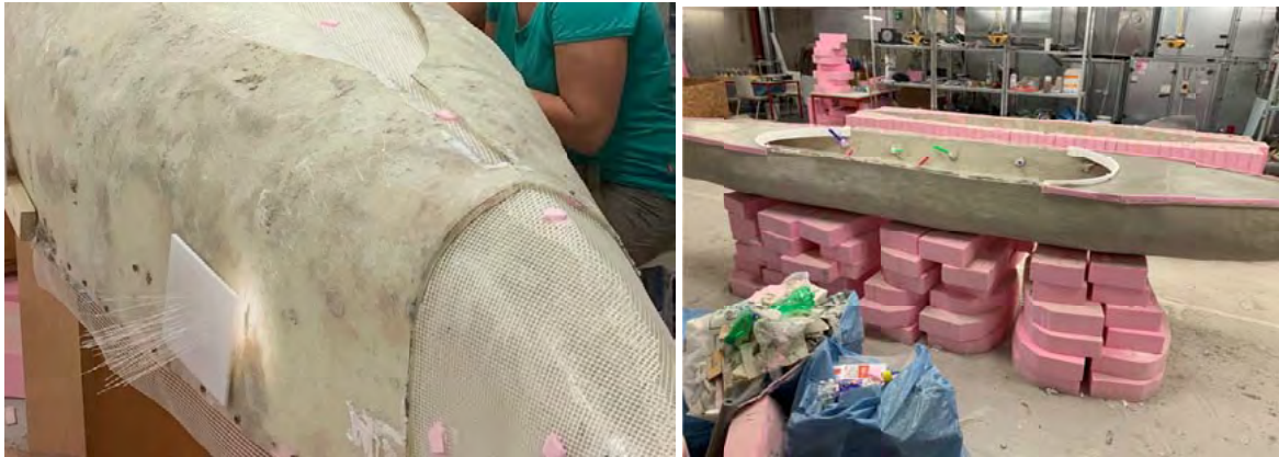
Abb 4. Durchführung der Lichtleiter bei teilweise geschlossener Schalung
