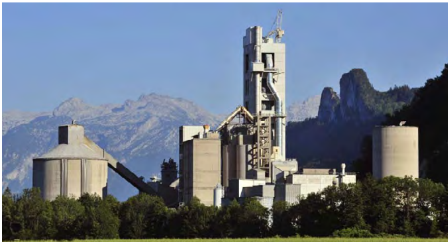
Abbildung 1: Zementwerk LEUBE, St. Leonhard, Werksansicht Richtung Süden
