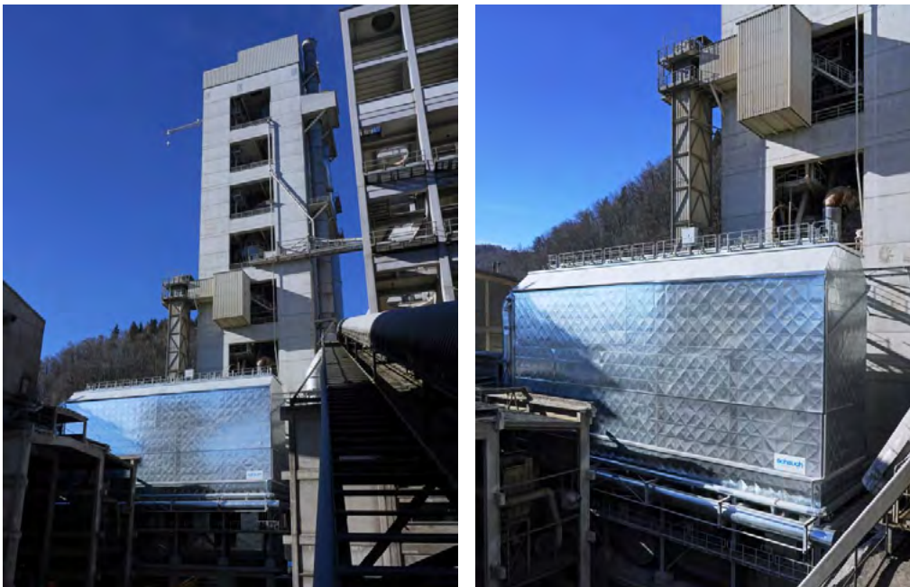
Abbildung 4: Fertiggestellte DeCONOX-Anlage im März 2019
