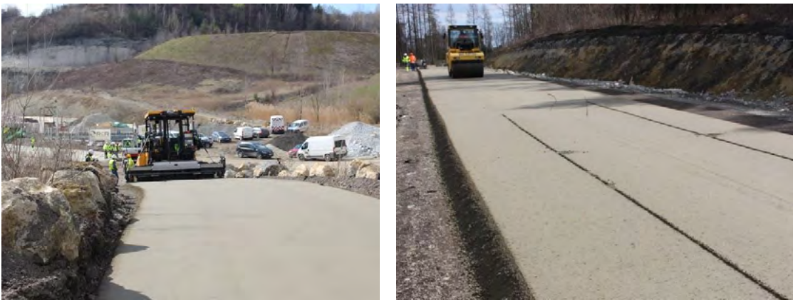
Abbildung 1: links: Betoneinbau mit Volvo Kettenfertiger; rechts: Nachverdichtung mit Glattmantelwalze
