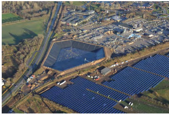
Abbildung 1: Bisher größter existierender Großwärmespeicher, ein wassergefüllter Erdbeckenspeicher mit einem Speichervolumen von etwa 200.000 m 3 in Vojens, Dänemark (Quelle: Arcon-Sunmark)
