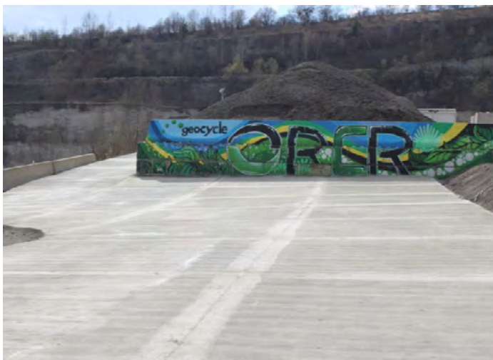
Abbildung 4: Betonoberflächen nach dem Schneiden der Fugen
